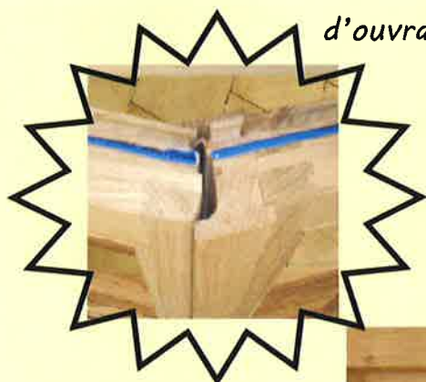
Fermeture à mouton et gueule de loup (avec crémone apparente)
