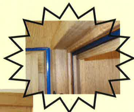
Joint polyuréthane sur dormant et sur ouvrant
